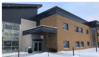
CHSLD DE CHAUFFAILLES 60, rue de Chauffailles Rivière-du-Loup (Qc) G5R 4E1
